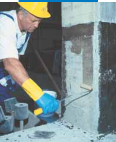
Applicazione della 1ª mano di MapeWrap Primer 1
