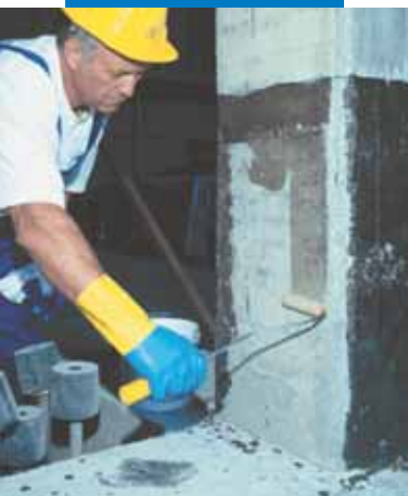
Applicazione della 1ª mano di MapeWrap Primer 1
