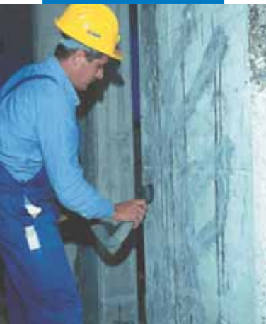
Preparazione del supporto
