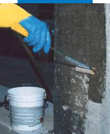
Applicazione della 2ª mano di MapeWrap Primer 1
