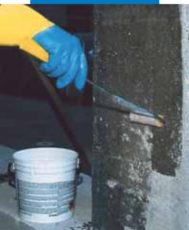
Applicazione della 2ª mano di MapeWrap Primer 1
