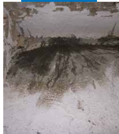
Connessione puntuale realizzata mediante MapeWrap B FIOCCO
