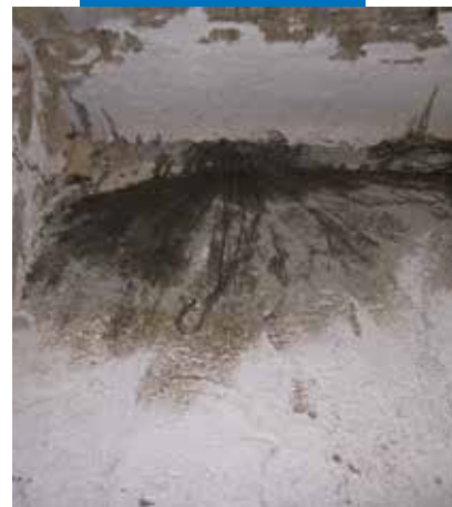
Connessione puntuale realizzata mediante MapeWrap B FIOCCO
