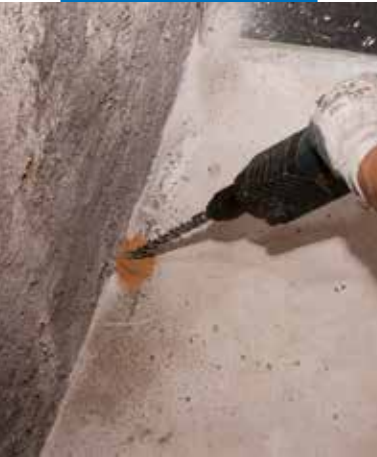
Realizzazione di foro
