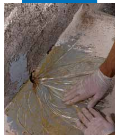
Apertura a ventaglio di MapeWrap FIOCCO
