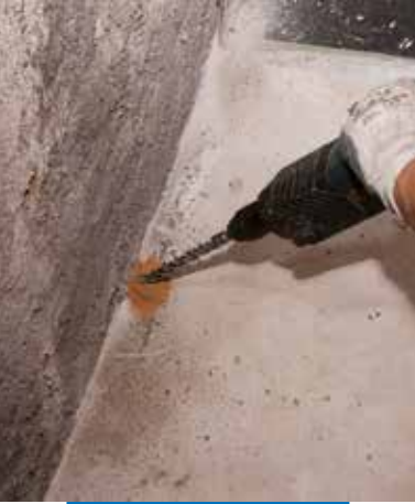
Realizzazione di foro
