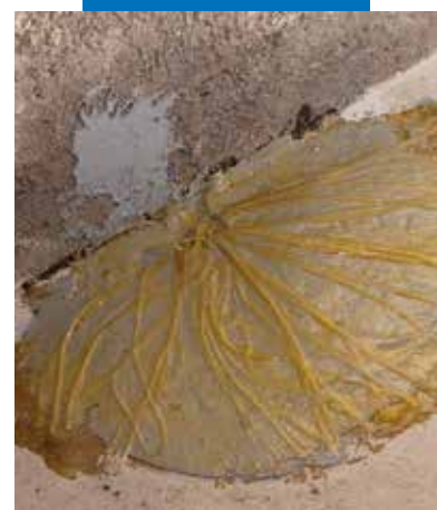
Impregnazione di MapeWrap FIOCCO
