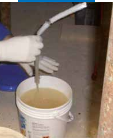
Impregnazione di una porzione di MapeWrap FIOCCO
