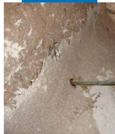
Inserimento di MapeWrap FIOCCO nel foro
