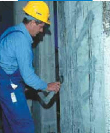
Preparazione del supporto
