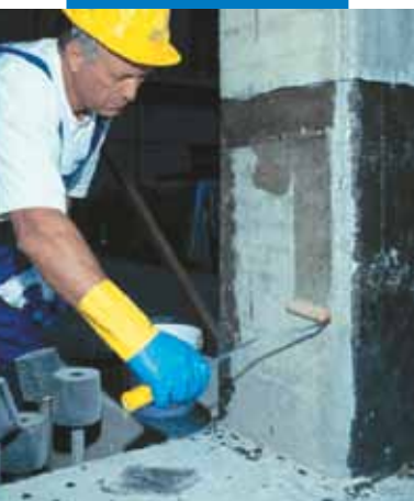
Applicazione di MapeWrap Primer 1
