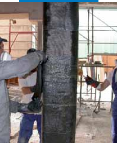
Impregnazione a secco di MapeWrap C UNI-AX HM con MapeWrap 31
