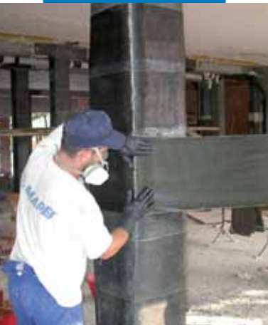
Confinamento di una colonna con MapeWrap C UNI-AX HM
